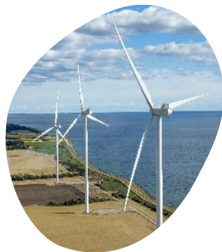
Windpark Mads - Dänemark Near-Shore Windpark mit 7 Turbinen Neuerrichtung in 2017
